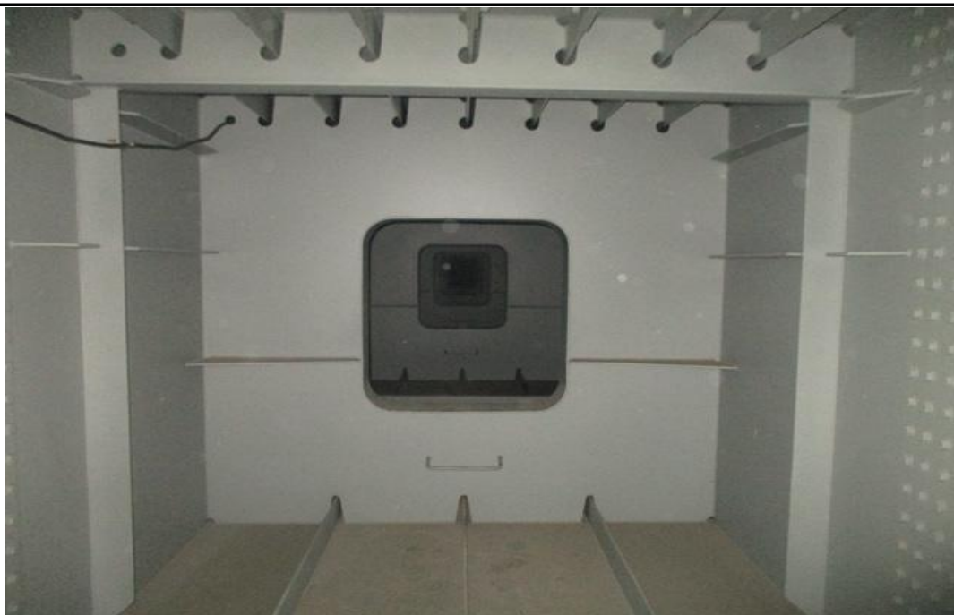
강박스 내부 전경
